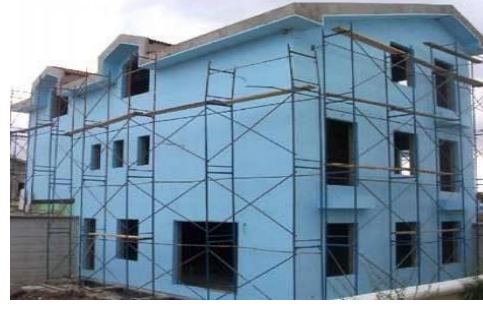
Şekil 172: Yalıtım malzemesi uygulaması
