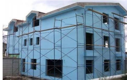
Şekil 177: Yalıtım malzemesi uygulaması
