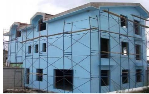
Şekil 190: Yalıtım malzemesi uygulaması
